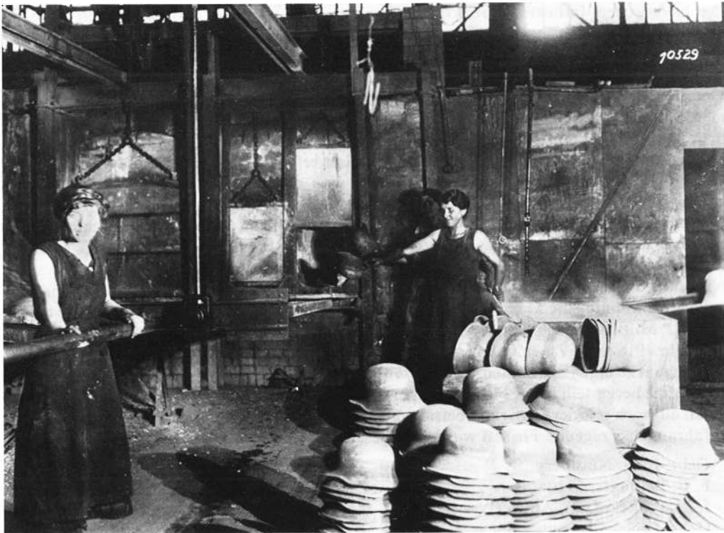
Kat.-Nr. 62 Herstellung von Stahlhelmen um 1918
