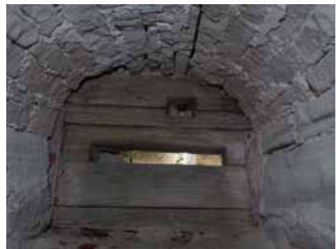
Abb. 15 Veste Coburg, Erster Mauerturm, unteres Geschoss mit eingesetztem Balkenschirm mit Schartenausschnitten (1420er Jahre)
