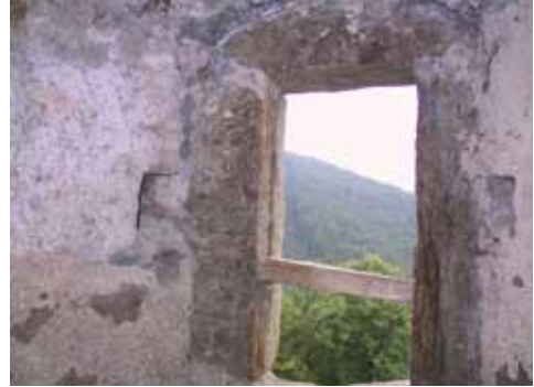
Abb. 13 Burg Augstein (Wachau, Österreich) Aussparungen in den Seitenwangen ermöglichen das Einschieben loser Hölzer.
