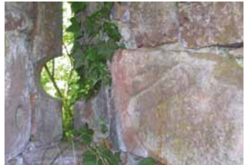
Abb. 14 Schlüsselscharte auf der Burganlage von Ottrott (Elsass) Deutlich sichtbar ist die exakt ausgearbeitete Führungsrinne zum sicheren Einlegen eines Prellholzes.
